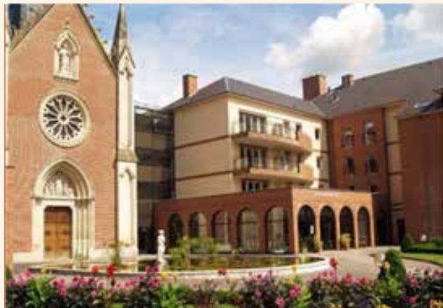
Chapelle hôpital de Louviers
