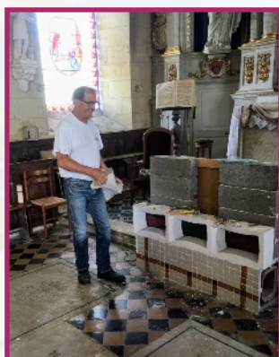
L'autel en cours de démolition
