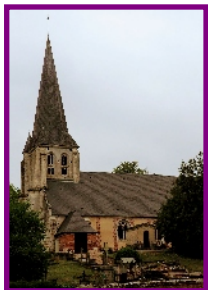
Montfort : Coordinateur et travaux
